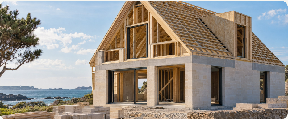
Photo illustrative : vue d'ensemble de l'avancement visible.
